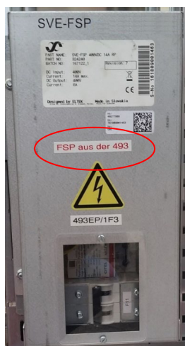
Abbildung 12: Beschriftung der SVE-FSP /PDU
