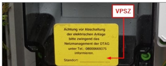
Abbildung 3: Beschriftung VPSZ am Zählerkasten
