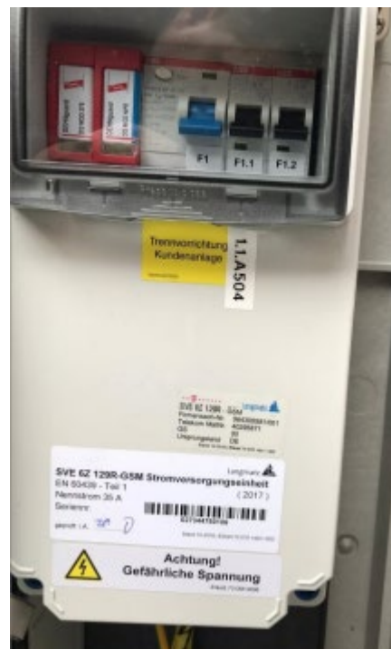
Abbildung 4: Beschriftung des Sicherungsgehäuse
