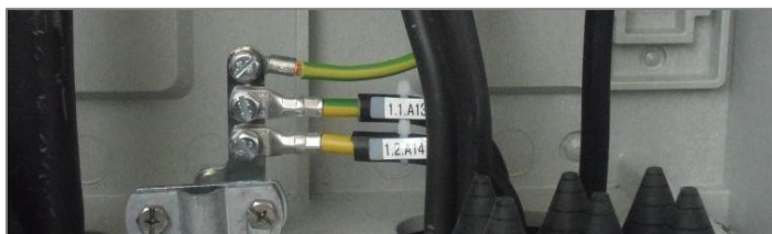
Abbildung 6: Haupterdungsschiene in der EnAs
