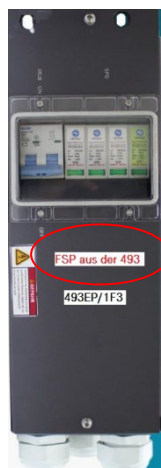
Abbildung 12: Beschriftung der SVE-FSP /PDU
